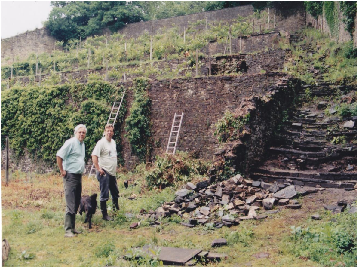
Deux anciens présidents de la Confrérie au moment du début des travaux de rénovation de l'escalier en 1998: André Sterckx et Richard Kermer. Les pierres de celui-ci sont enlevées après avoir été numérotées. (archives de Guy Boone)
