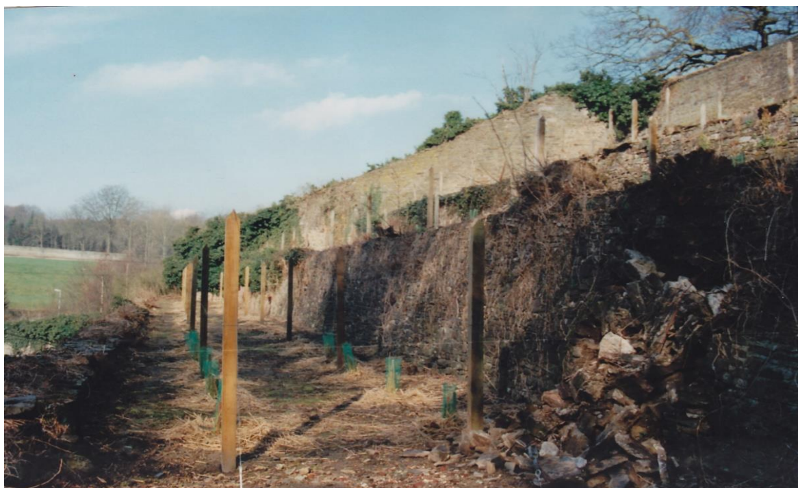
Photo du mur démoli d'une des deux terrasses (archives de Guy Boone)
