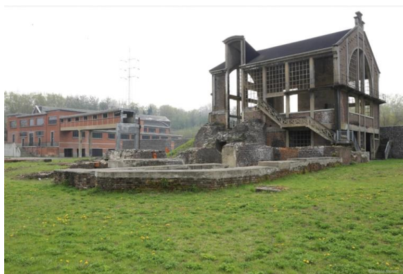
La ruine intégrée de l'ancienne salle des machines du puits d'extraction
